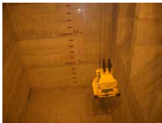
まだ、ごみが入っていないピット
