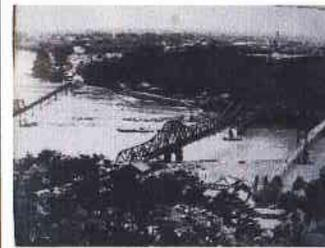
明治44年10月、現在の鹿島橋の上流側に天竜橋が竣工した。木鉄混合の吊り橋（写真一番右）。全長225m、幅3m。初めのうちは賃取り橋で、大正15年静岡県に移管され、無賃となった。昭和に入ると、自動車の重量に耐えられず橋幅も狭く人車とも危険ということで、昭和12年8月、鹿島橋が竣工した。
