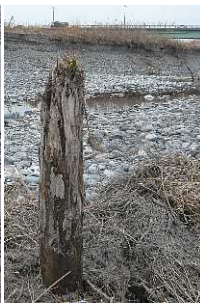
残された橋脚
