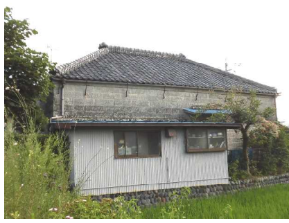
② 椋本家 伊豆石の住宅 大正12年建築、住居兼店舗。平屋建てだが、軒高が高く梁は二重。火災に備えた。
