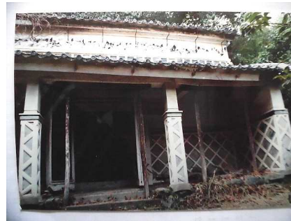
⑤ 源馬家 土蔵 現存しない なまこ壁。明治時代、笠井で綿織物の源馬商店を営む。庄カネショウの軒瓦がある。
