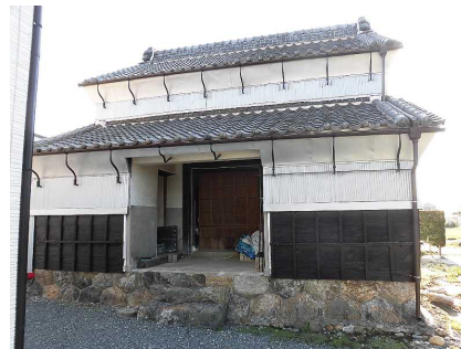
⑧ 大村家 土蔵 建築年は不明。漆喰壁はトタンで補修。雨樋受けの折れ釘が大きく飾りとなる。
