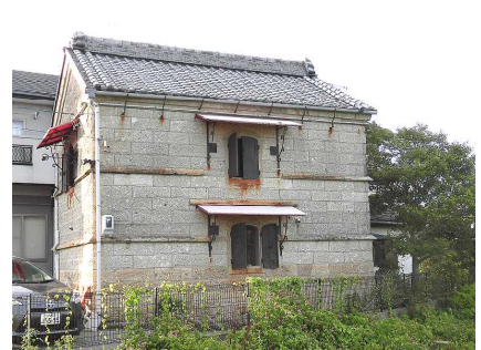
⑥ 市川家 伊豆石の倉 昭和3年市川利一郎氏建築。庄マルショウの軒瓦。戦前綿織物業の倉として使用。
