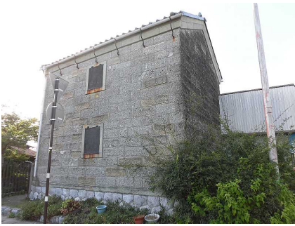
① 椋本家 伊豆石の倉 昭和11年、大瀬にあった米倉を移築。入り口は店舗から続く。商品倉庫とした。
