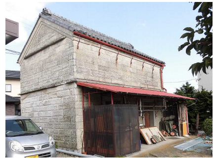
③ 花井家 伊豆石の倉 明治の終わりごろ建築。藍染め用の倉として使用。横に藍染め作業場があった。
