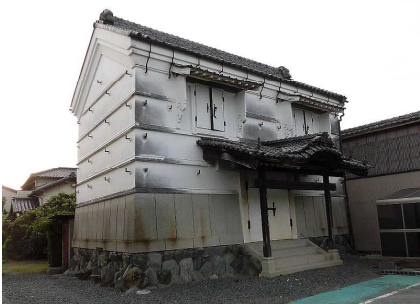
⑩ 中安家 土蔵 大正10年建築の最大級の土蔵。折れ釘が並ぶ。唐破風の瓦葺きひさは、昭和6年建築で七福神の瓦像が載る。共に中安時十郎氏建築。地窓(床下換気口)の石扉に命の屋号、軒瓦に家紋が付く。戦前より山中織物を営む。米などの倉として使用。
